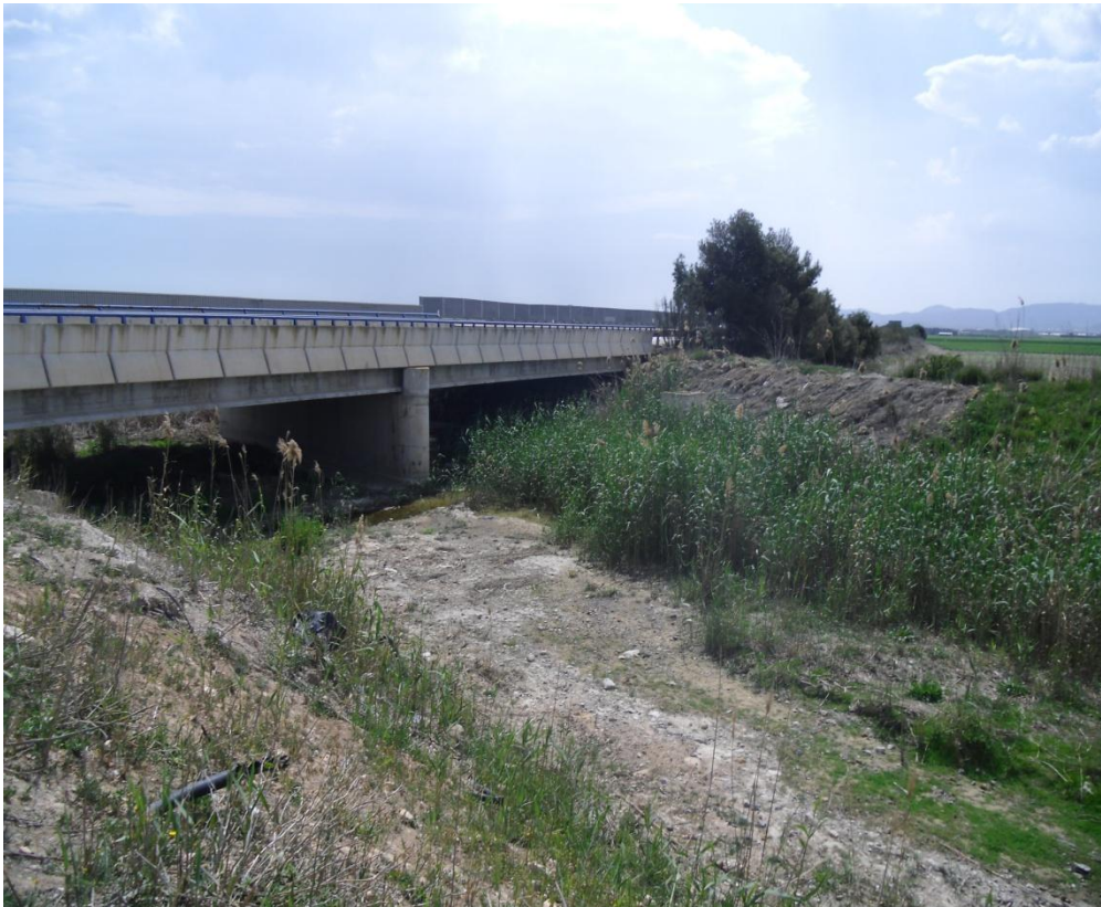
Figura 9.2 Estructura puente correspondiente a la autopista AP-7.
