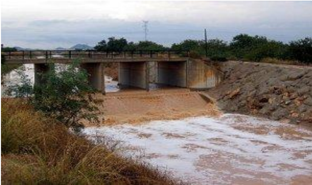
Figura 5.1 Puente camino de servicio en las proximidades del ferrocarril, Rambla del Albuñón.
