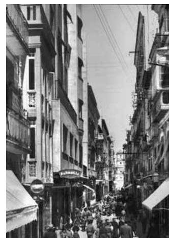
Figura 4. Viviendas en Trapería. Murcia. J.L. de León (1943).
