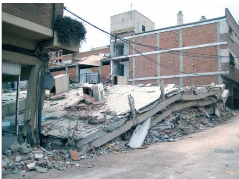
[Foto 1] .- Colapso de un edificio en Lorca (Murcia) debido al evento sísmico principal ocurrido el 11 de mayo de 2011.
