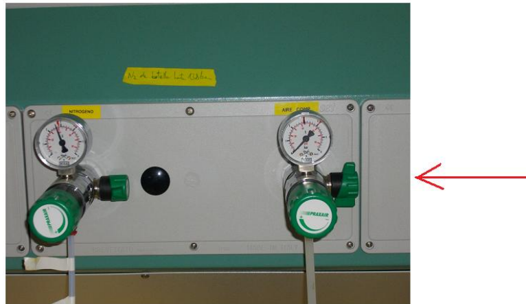
Figura 2.3. Llaves de aire comprimido (derecha) y de Nitrógeno (izquierda)
