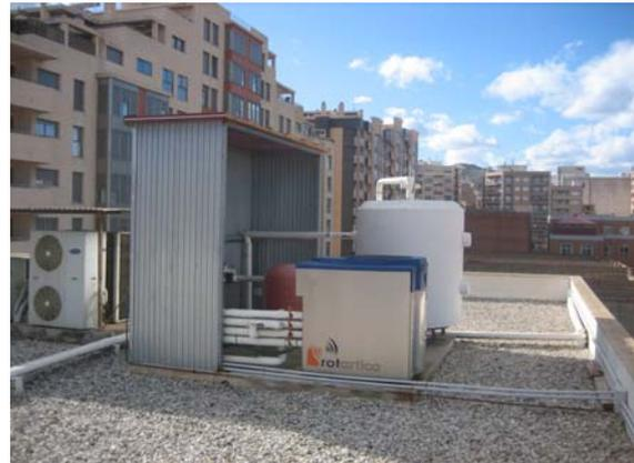
Fotografía 2. Instalación de refrigeración solar en la Universidad Politécnica de Cartagena
