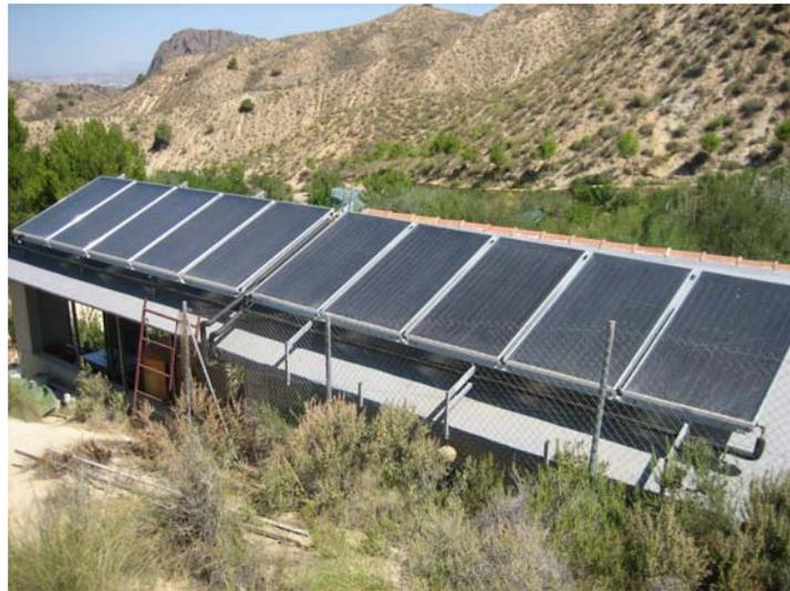
Fotografía 29. Colectores solares de la instalación de Fuente de Columbares.
