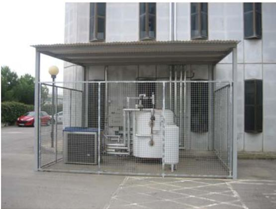
Fotografía 9. Instalación de refrigeración solar en el Centro Regional de Industria y Energía
