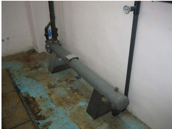
Fotografía 39. Intercambiador de calor del circuito de disipación.
