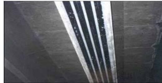
Fig.6.4. Reparación de Estructuras de hormigón con laminados de fibra de carbono. Reparación del tablero del puente de la Avda. de .Luis, sobre la M-30.
