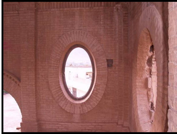
Detalle del marco de ventana.
