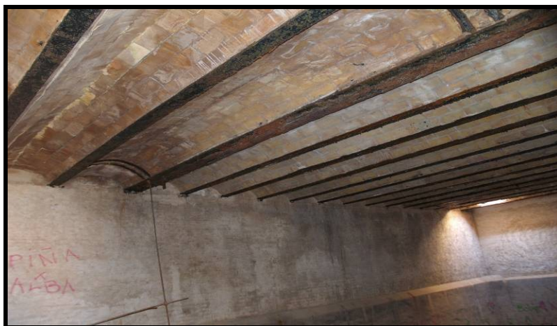
Detalle general del forjado
