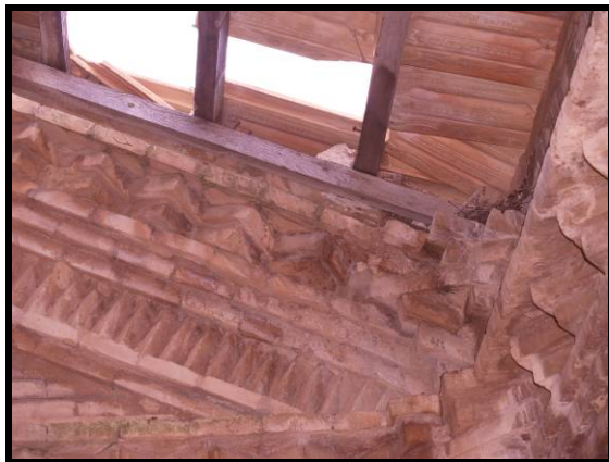
Detalle de rastreles de madera.
