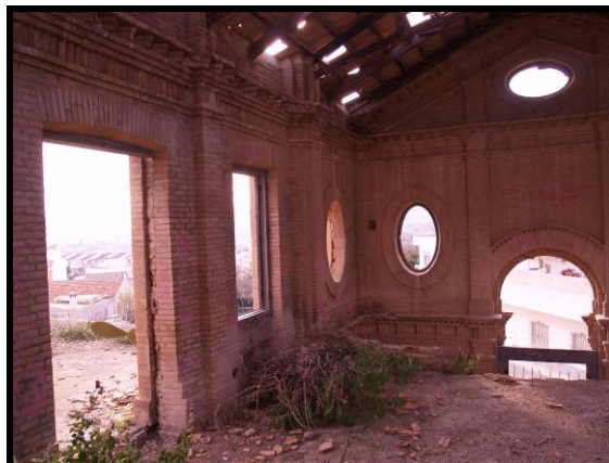
Detalle de biodeterioro 2.
