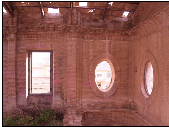
Detalle general de la fachada interior.
