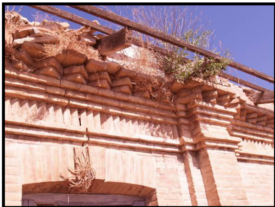
Detalle de biodeterioro 1.
