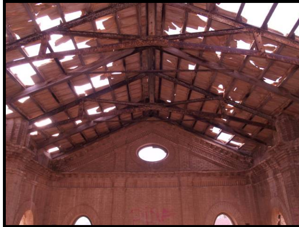
Detalle general de las cerchas.
