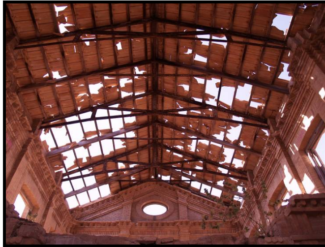
Fotografía general de cómo apoya las cerchas en la fabrica
