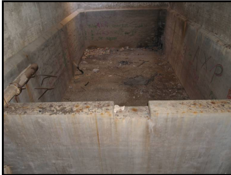
Fotografía general del interior del deposito
