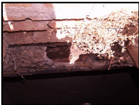
Detalle biodeterioro 3.
