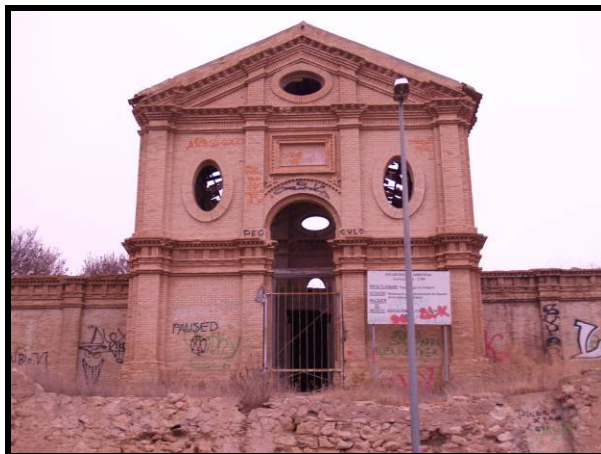
Detalle general de la fachada principal con la reja de acceso.
