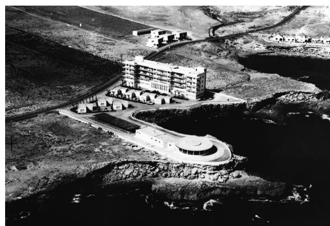
Figura 10. Vista general del Complejo Sindical de Turismo Social en el Torrejón finalmente ejecutado, con el restaurante en primer plano. Fuente: ACTAA.
