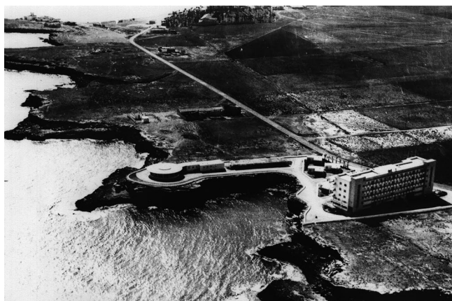
Figura 6. Vista general del Complejo Sindical de Turismo Social en el Torrejón finalmente ejecutado. Fuente: ACTAA.
