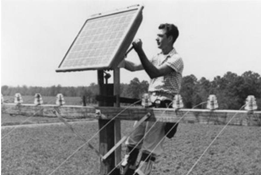
**Figura 1: Panel solar fotovoltaico de Laboratorios Bells utilizado en una primera prueba en 1955 en Americus, Georgia**
