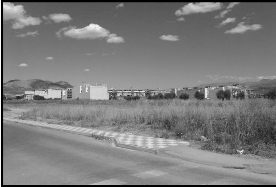
Imagen 09.- Núcleo inconexo y diseminado. Una nueva fachada de espaldas a la ciudad. Albolote, Granada (Fuente: Elaboración propia)
