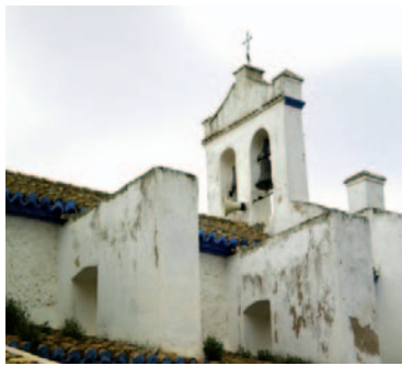
Figura 20. Iglesia de Perín. Detalle de los contrafuertes exteriores.
