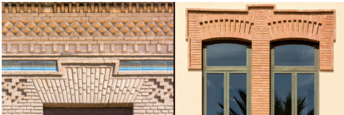
Fotografía 14. Utilización del ladrillo prensado. Izquierda, ladrillo prensado de borde biselado en dintel y liso en cornisa. Vivienda en C/ Miguel de Bobadilla, La Palma. Derecha, parteluz y arcos en ladrillo prensado de canto recto. Quinta de San Sebastián (Casa del Reloj), San Pedro del Pinatar. (Fotografías del autor).
