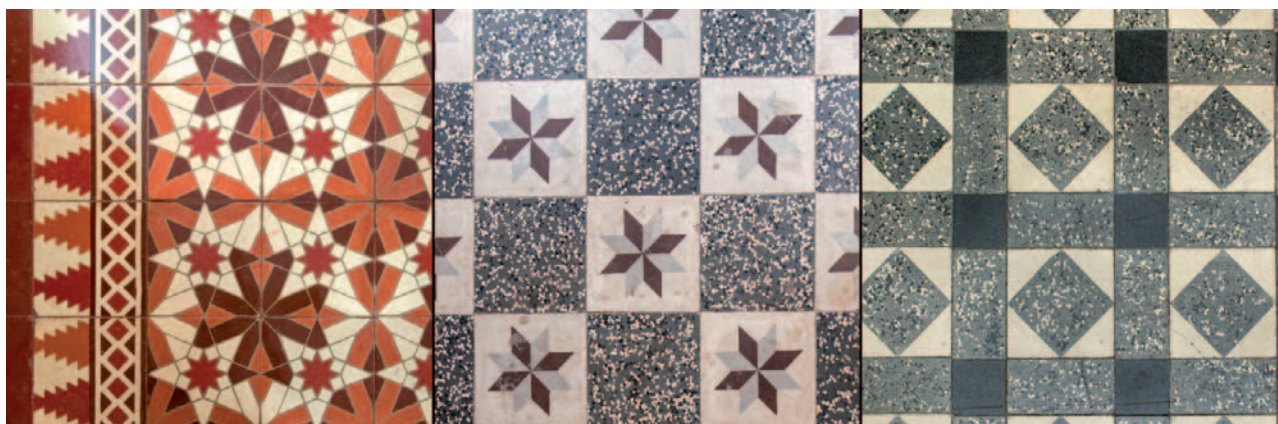
Fotografía 10. Distintos diseños de mosaico hidráulico. Izquierda, modelo neoárabe de vivienda en Balsapintada. Centro, modelo que alterna flores con baldosa imitación granito, en Villa Clara (Santa Ana) y derecha modelo sencillo de hidráulico pero colocado de forma muy atractiva (Vivienda en C/ Castelar, El Algar). (Fotografías del autor).
