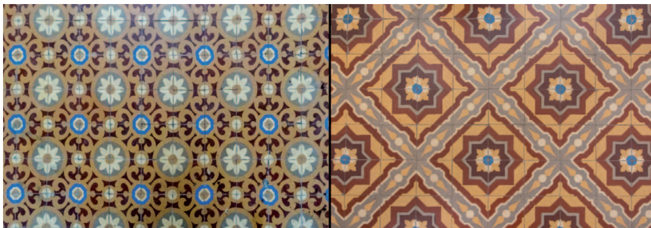
Fotografía 12. Pavimentos de cerámica incrustada al fuego. Izquierda modelo de Romeu Escofet en la Finca 1900 (Dip. El Plan). A la derecha modelo de Romeu Escofet en Finca El Molinar (Ctra. La Palma). (Fotografías del autor)
