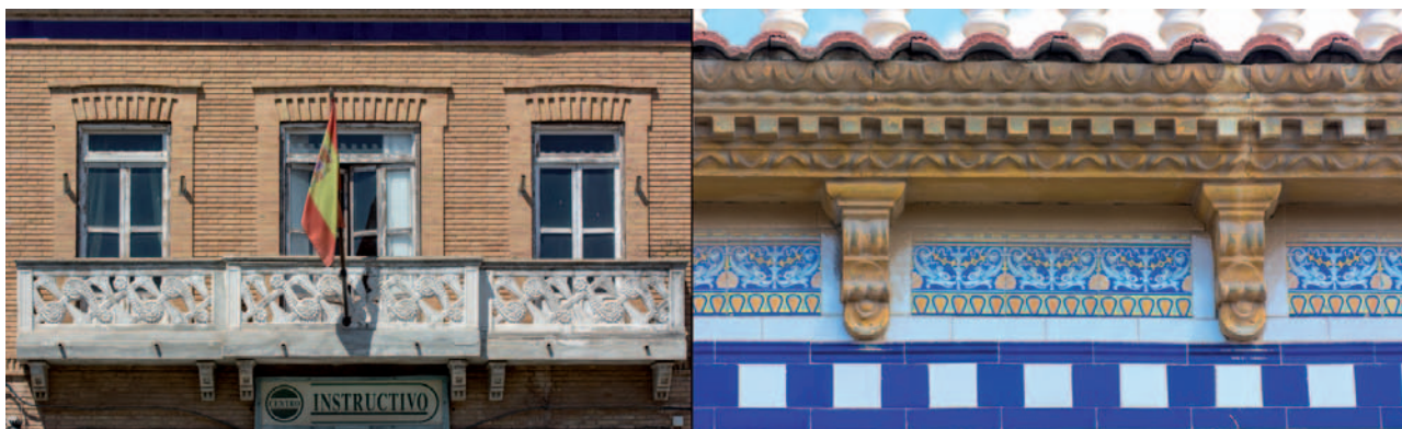
Fotografía 6. Elementos de piedra artificial en fachada. Izquierda, balaustrada diseño decó en el Centro Instructivo de Pozo Estrecho. Derecha, cornisa decorativa y ménsulas en piedra artificial, con decoración en azulejería correspondiente a una vivienda en la C/ Mayor de Canteras. (Fotografías del autor)
