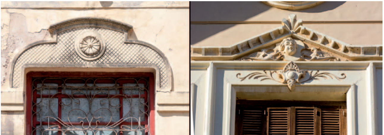
Fotografía 4. Guardapolvos de piedra artificial. Izquierda Chalet Don Mario (El Jimenado). Derecha Casa Rubio (El Algar). (Fotografías del autor)
