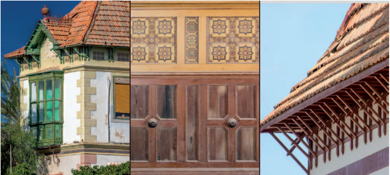
Fotografía 25. Distintas realizaciones en madera. Izquierda, Villa 1900 en la Diputación de El Plan. Magnífico ejemplo de vivienda burguesa con aleros pronunciados de madera con jabalcones, frente de alero con guardamalletas y mirador en el primer piso. Centro, Vlla Antonia, Diputación de Pozo Estrecho, zócalo de madera de uno de los salones, revestimiento muy habitual en las viviendas burguesas. Derecha. Alero de madera con jabalcones de en Villa El Retiro, en San Javier. (Fotografías del Autor).
