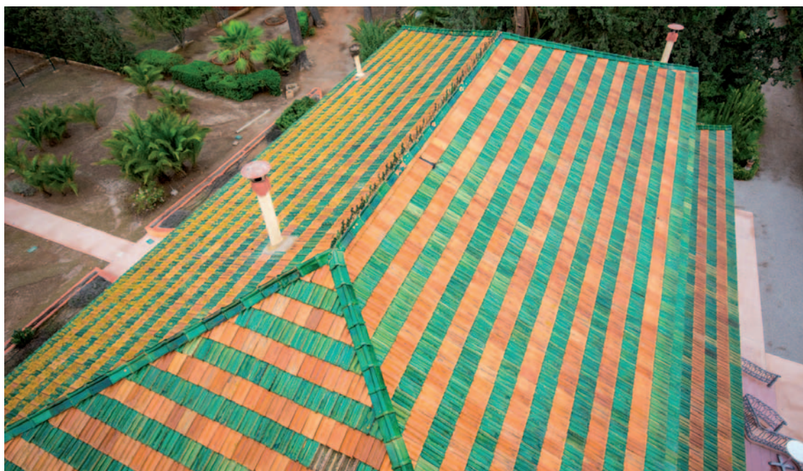
Fotografía 16. Magnífico ejemplo de teja vidriada con crestería de la casa Romeu Escofet, de Barcelona. Techo del edificio principal de la Torre Llagostera, diputación de El Plan. (Fotografía del autor).
