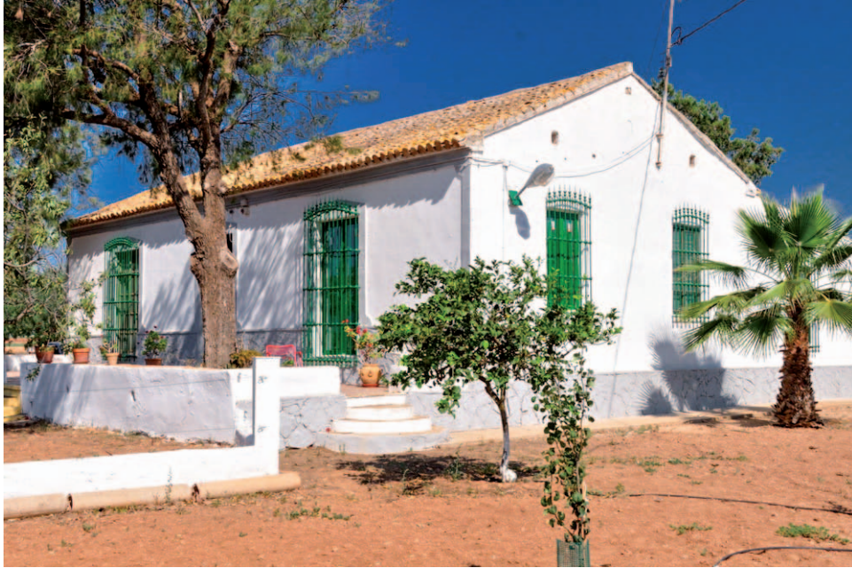
Fotografía 2. Vivienda tradicional sencilla del Campo de Cartagena, zona Los Beatos. Dispone de cubierta con teja curva sobre muros de mampostería encalados, carpintería de madera, rejería en ventanas, atrio delantero con bancos y patio trasero. (Fotografía del autor)
