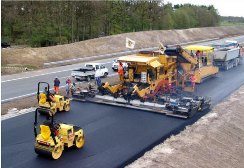
Figura (2): Construcción de carretera
