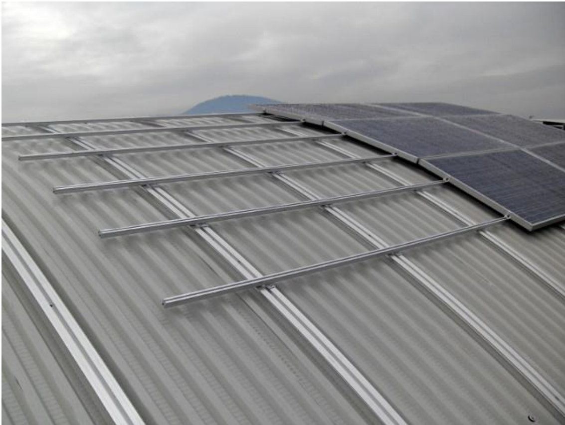
Imagen 16. Estructura panel techo curvo
