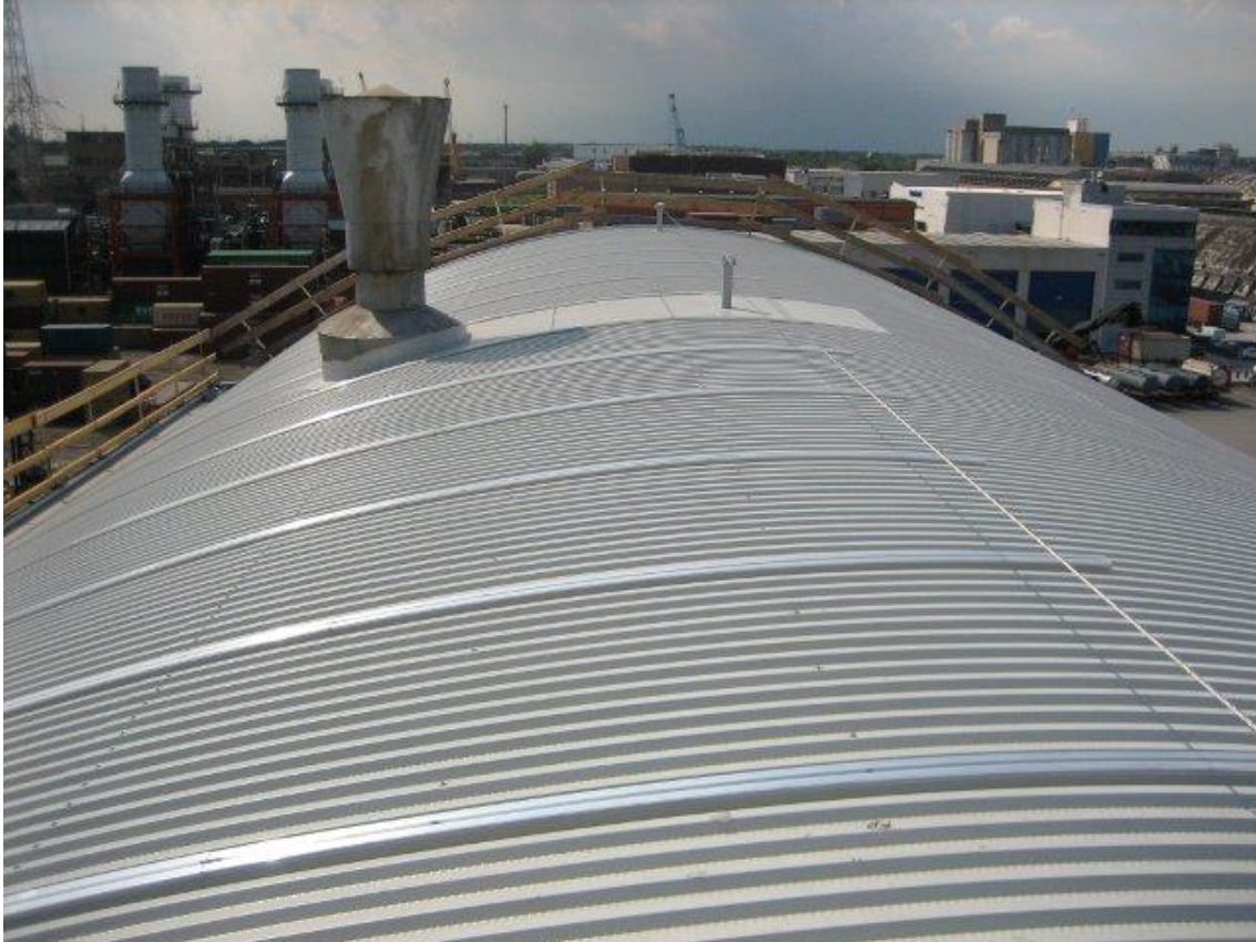
Imagen 15. Estructura paneles techo curvo [22]
