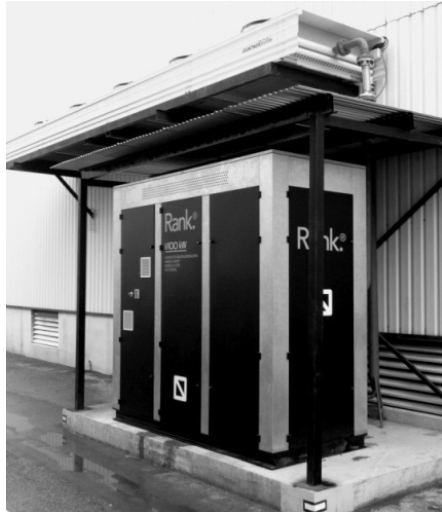
Figura 2: Módulo de recuperación de calor residual: (a) ORC y sistema de disipación instalados en el exterior de la planta industrial, (b) esquema básico del ciclo con la posición de los instrumentor de medida.
