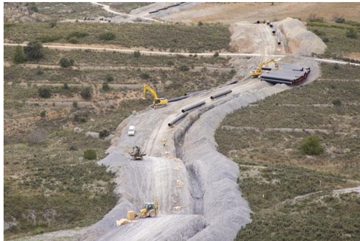
Figura 1.3.3: Construcción de un gaseoducto de transporte. Cortesía de Enagás [14].
