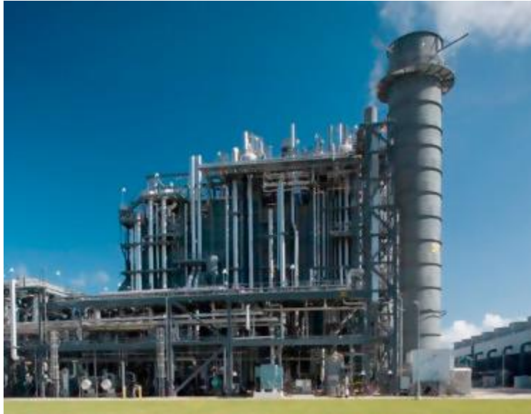
Figura 3.2.4: HRSG típico tamaño grande [35].
