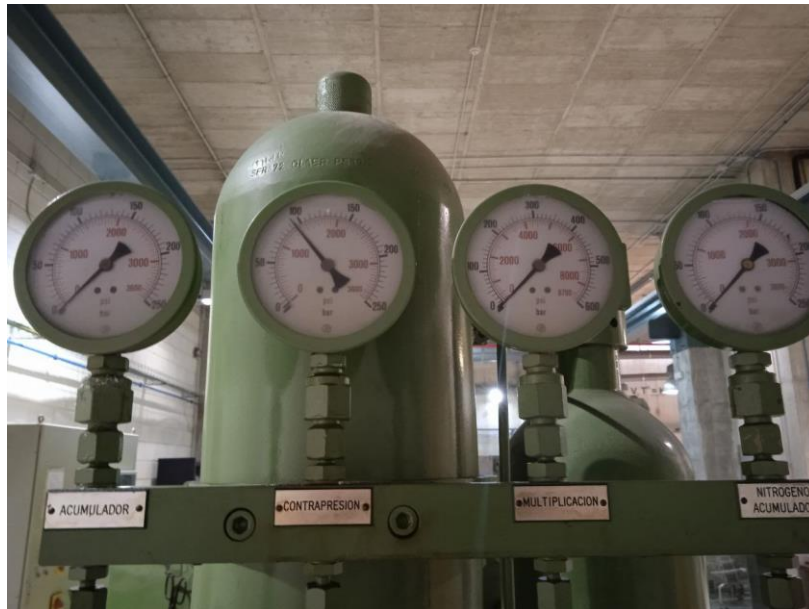
Figura 3.20 Detalle medidores de presión
