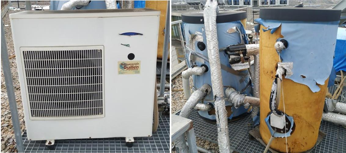
Figura 16. Enfriadora y depósito
