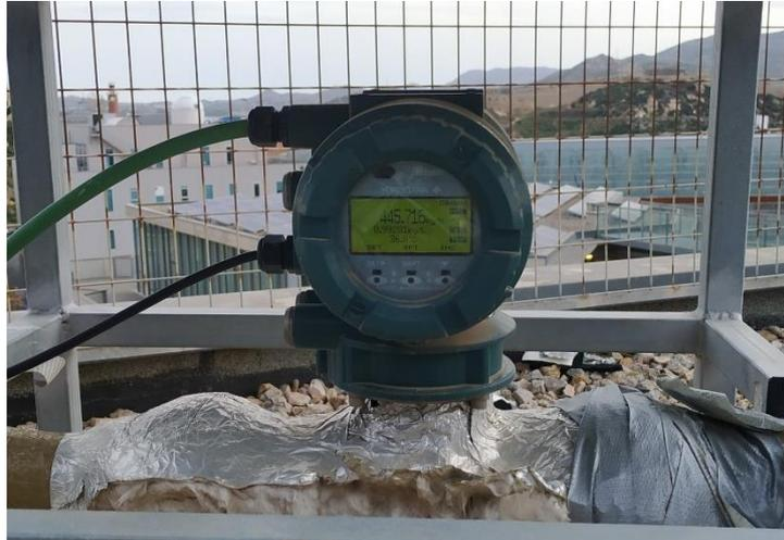
*Figura 17 Caudalímetro Coriolis*
