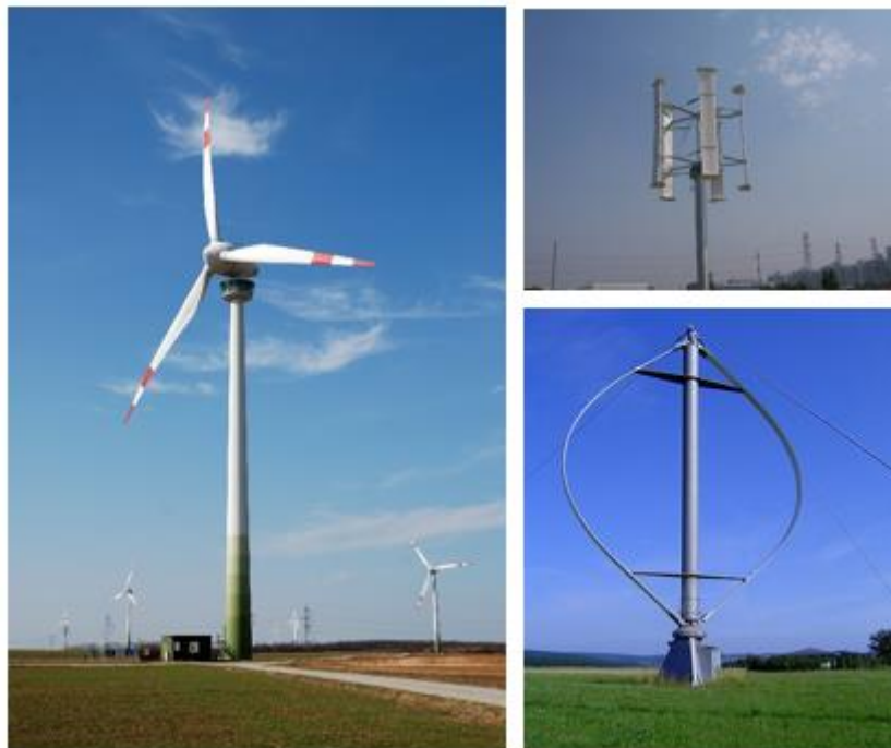
Figura 17. Aerogenerador de eje horizontal (izq) y de eje vertical (dcha)
