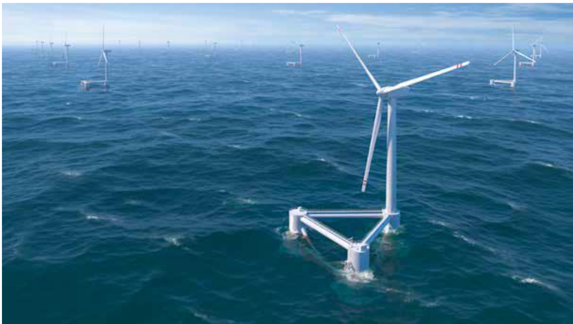
Figura 52. Parque eólico off-shore con plataformas flotantes
