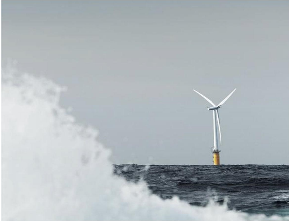
Figura 56. Hywind Demo, el primer aerogenerador flotante de 2,3 MW
