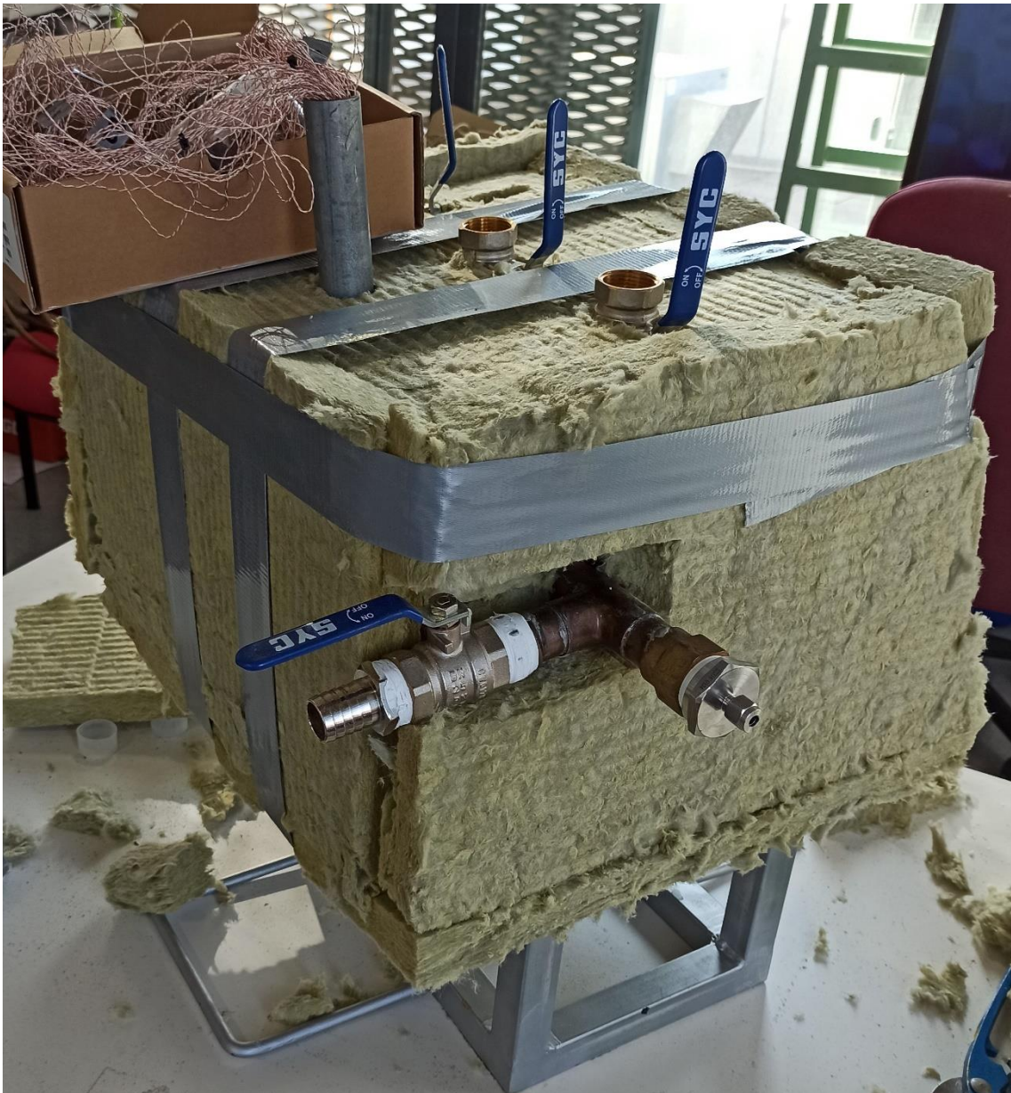
Figura 48. Acumulador aislado con lana de roca.
