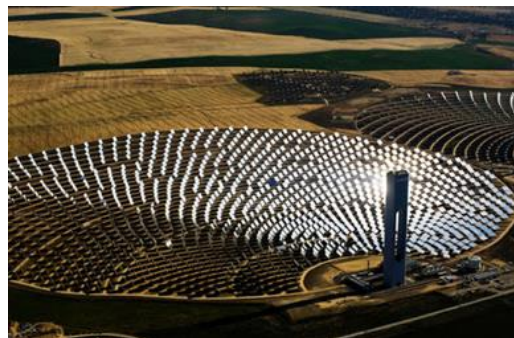
Figura 1b. Planta termoeléctrica PS10.
