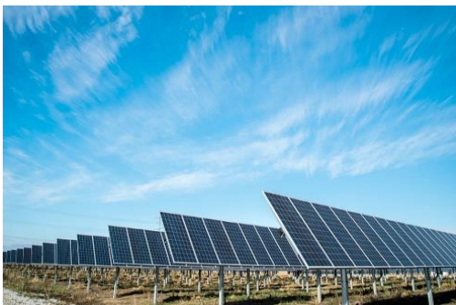
Figura 1a. Planta solar fotovoltaica PV10 Sevilla.
