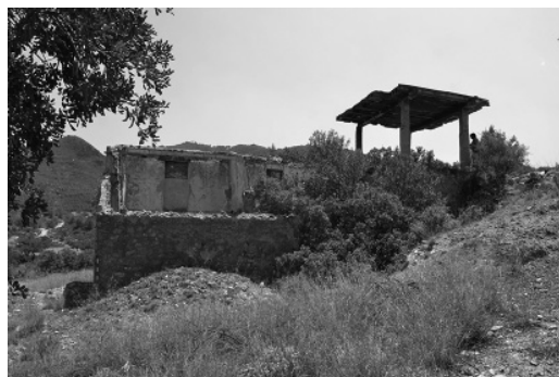
Figura 8 Fábrica de yeso con los hornos protegidos con una cubierta (Grau y La Spina, 2017)
