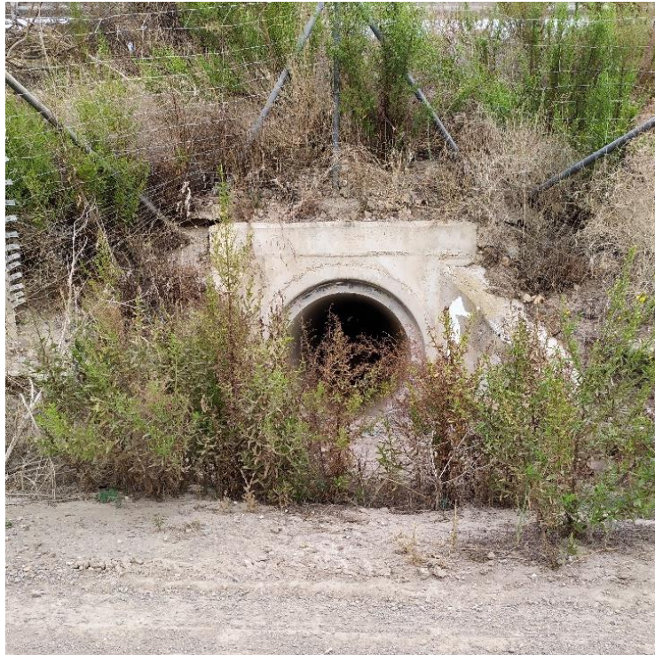
Figura 87. Tubo 800 mm. Situado en P.K.791+900.
