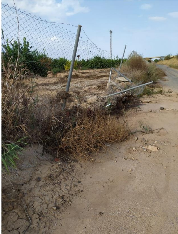
Figura 89. Aguas arriba de una ODT.
