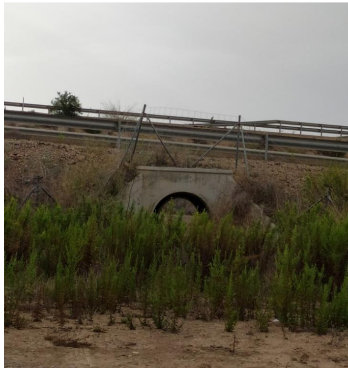
Figura 88. Tubo 1800 mm. Situado en P.K.789+200.
