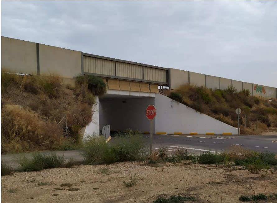
Figura 85. Marco 4x4 m. Obra de paso. Situada en P.K.790+370.
