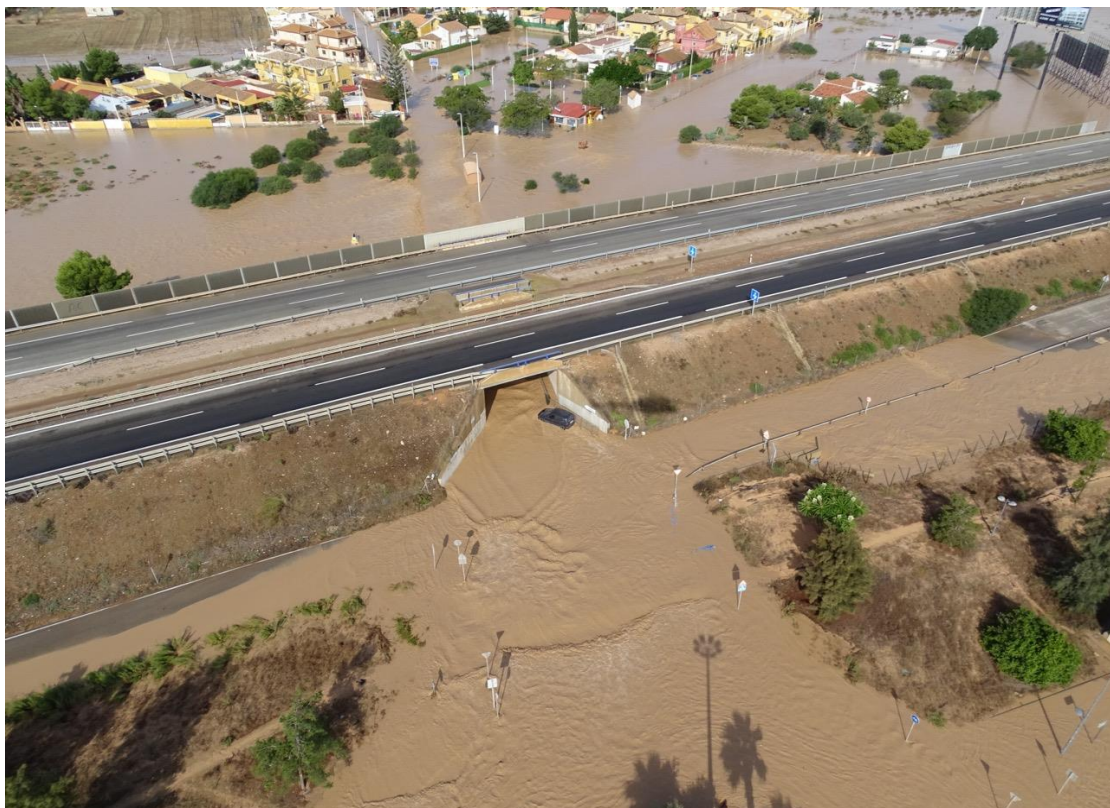
Figura 80. Vista aérea en detalle para marco 4x4. Efecto presa. Episodio DANA sept.2019. (Fuente: IMIDA,2019).
