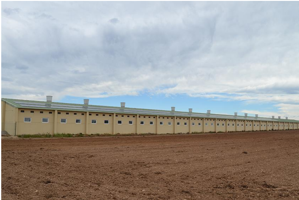
Ilustración 3 Instalación de paneles solares en techo de Granja porcina en Almacellas, España [3].
