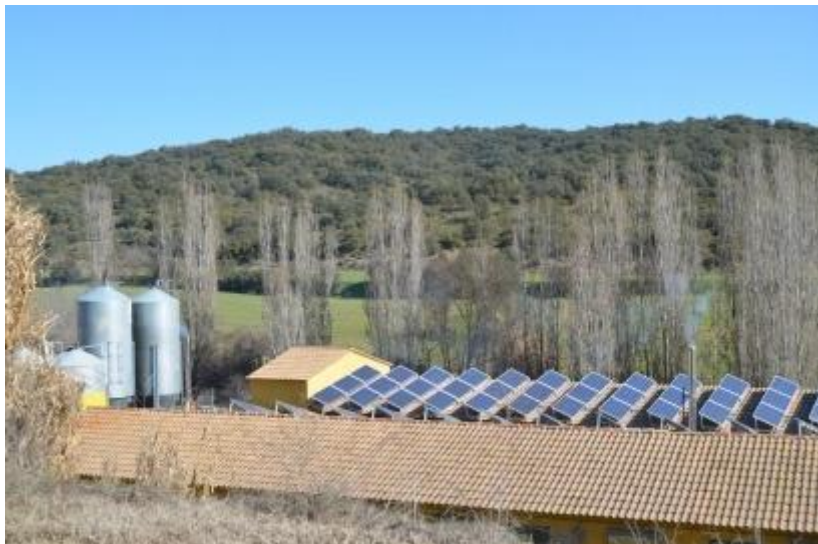
Ilustración 2 Instalación de paneles solares en Bon Lechó [2] .
