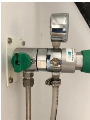
**Figura 3.2.4.2 Válvula del flujo de aire.**
