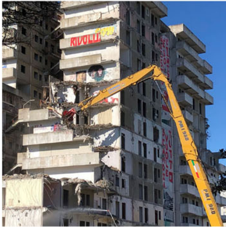
[14] FEBBRAIO 2020, INIZIO DEMOLIZIONI.
