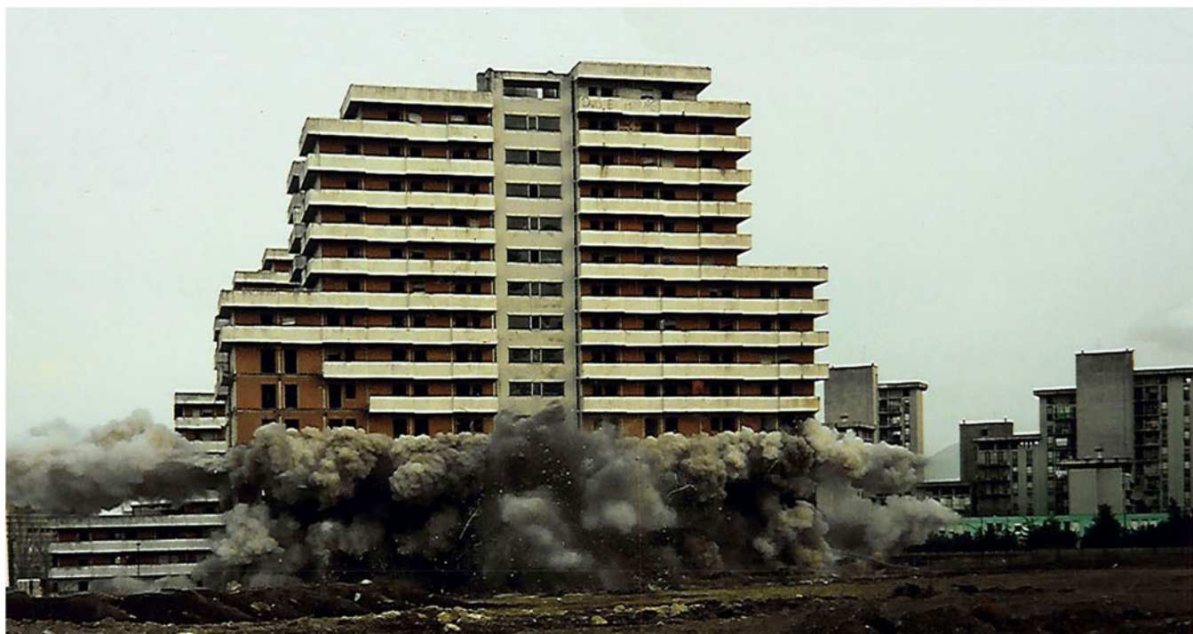
[5] QUARTIERE 167 DI SECONDIGLIANO, TIPOLOGIA "TORRE". L'ABBATTIMENTO.
