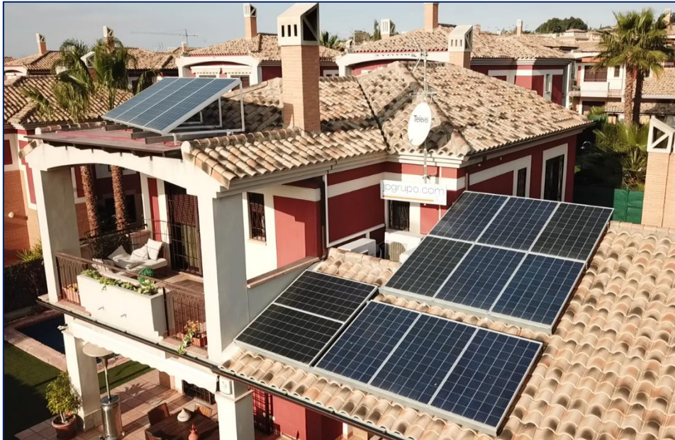
Fig. 5.2.3. Ejemplo de estructura orientada (izqda.) y estructura coplanar (dcha.)
