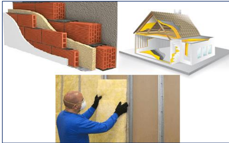
Fig. 2.2.2. Colocación de material aislante en paredes
