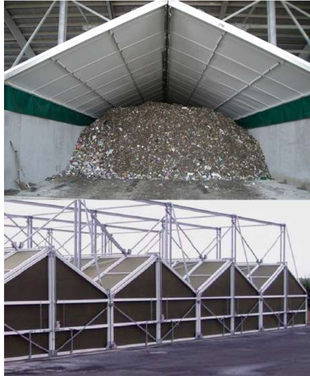
Ilustración 44 Sistema de compostaje en túnel. (Tortosa, 2015)
