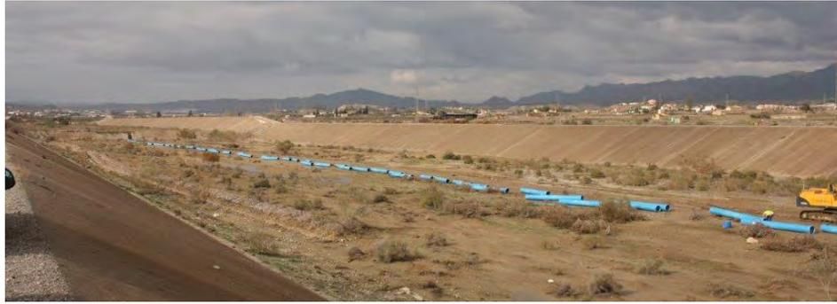
**Figura 4.** Tubería TOM® de PVC-O DN500 mm acopiada a lo largo de la traza.
