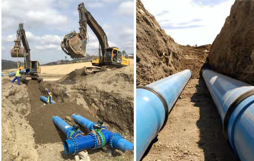
**Figura 8.** Detalle instalación Tubería TOM® de PVC-O DN500 mm
