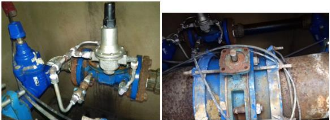
Figura 2.14: Válvula reductora Casco Antiguo.
