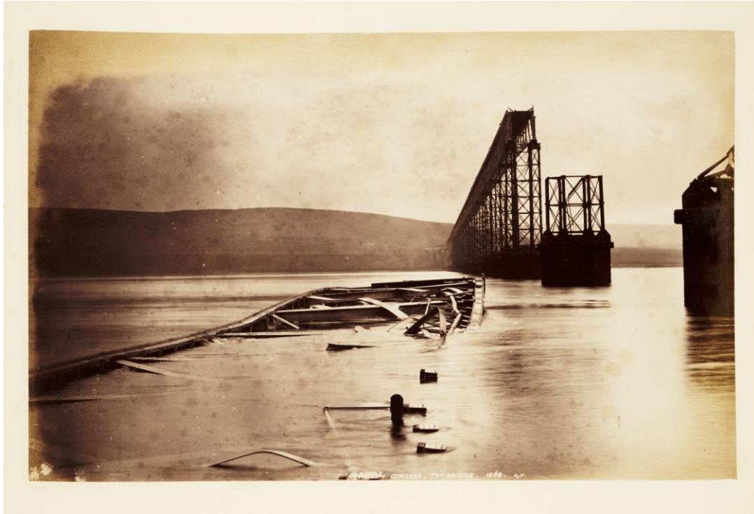
Figura 2.10 - Vigas caídas del puente Tay Rail. 13
