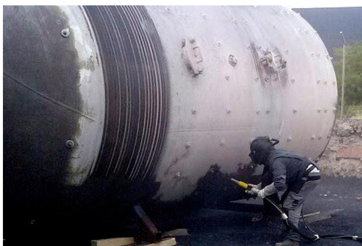
Figura 19. Proceso de chorreo de arena
