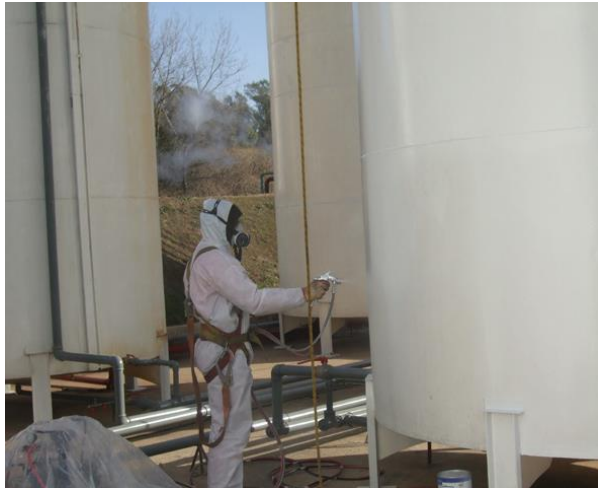
Figura 22. Proceso de pintura
