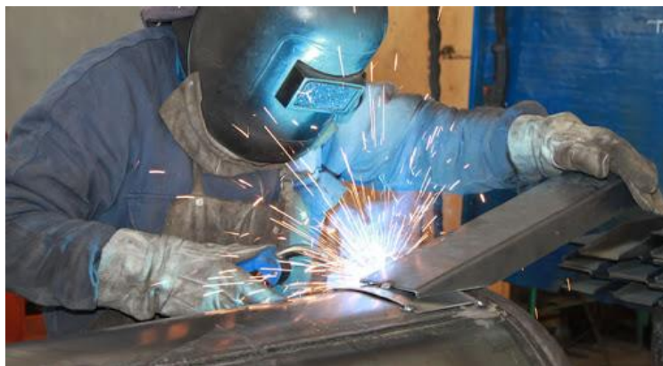
Figura 18. Proceso de soldadura
