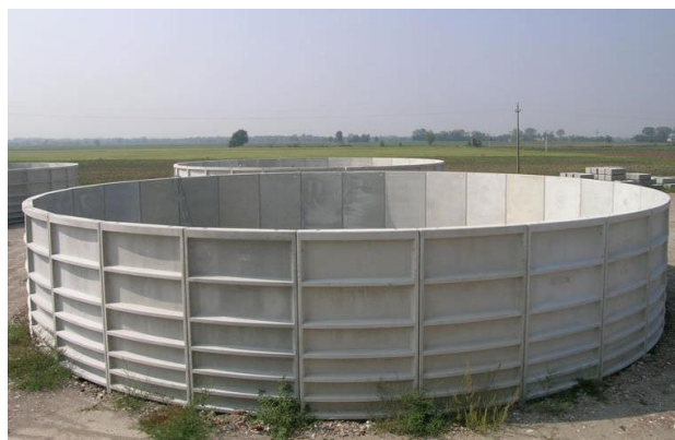
Figura 13. Tanque de hormigón
