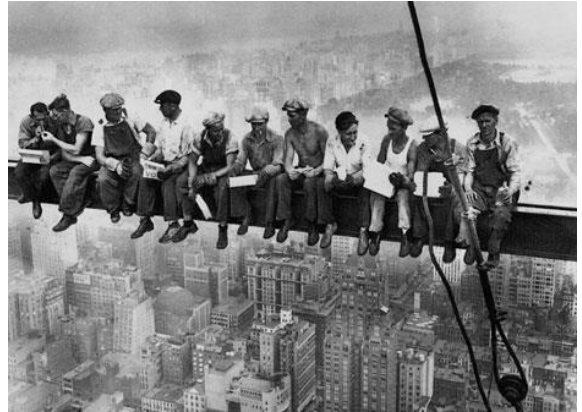
Figura 2. Obreros en un descanso en malas condiciones de seguridad
