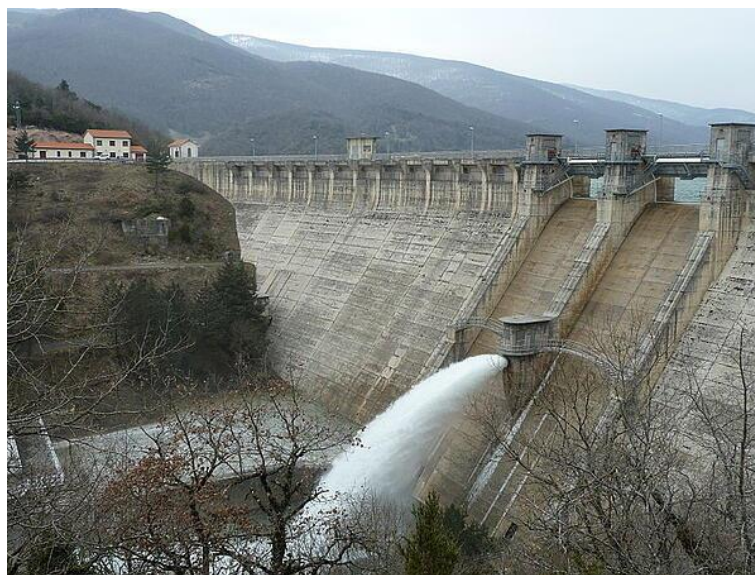
Figura 1. Presa de Eugui. (Fuente: Structuralia)
