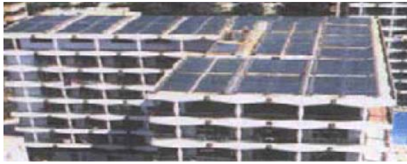
Fotografía X. Campo de colectores de vacío en la cubierta del Hotel Belroy Palace.
