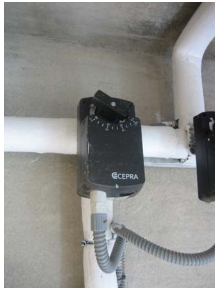
Figura XLIII. Válvula de tres vías motorizada.
