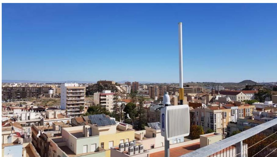
Figura 4.9. Estación base LoRaWAN instalada.
