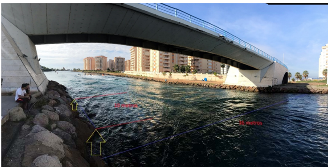
Figura 10: Puente elevadizo con dimensiones
