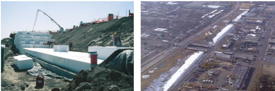
Figura 12. Utilización de bloques de EPS durante la reconstrucción de la Interestatal 15 (Aabøe, 2011)
