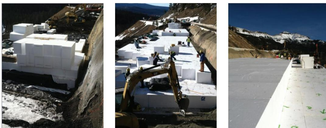
Figura 23. Etapas durante la estabilización del talud en el Paso de Cameron (ACHfoam, 2009)
