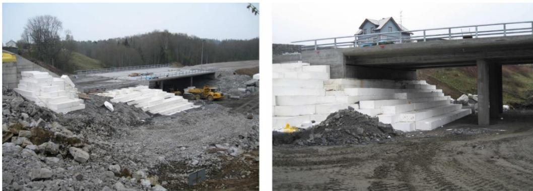
Figura 15. Terraplén de geofoam en el estribo del puente Almark (Damtew et al., 2011)
