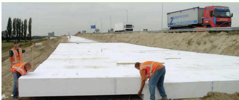
Figura 9. Ampliación de una carretera con bloques de EPS (Obras Urbanas, 2012)
