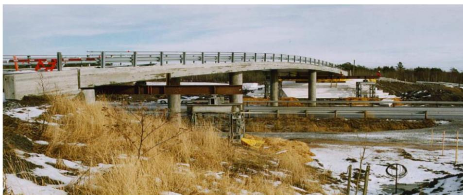
Figura 18. Soportes temporales durante la reconstrucción del Hjelmungen (Aabøe, 2011)
