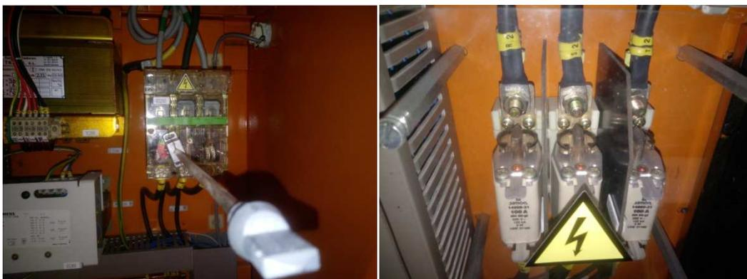
Figura 3-28: Transformadores de instrumentación, alimentación monofásica, contactor principal y fusibles
