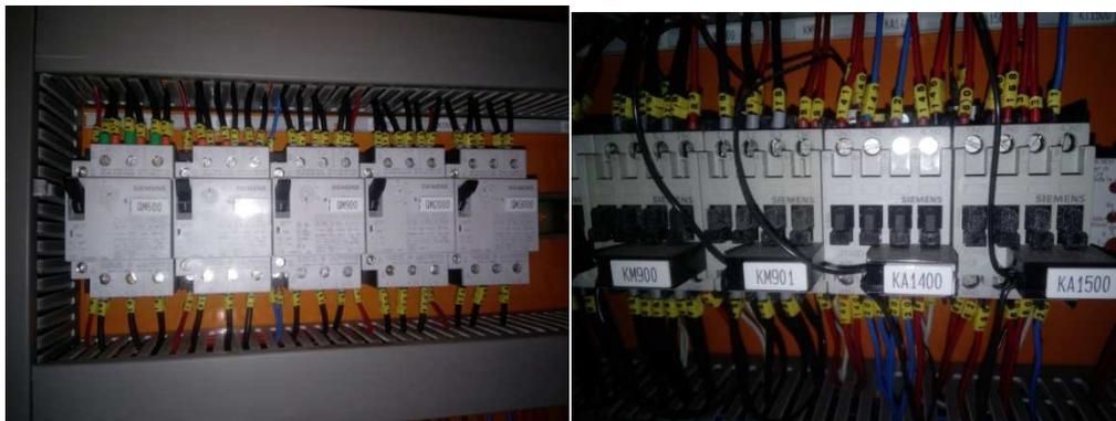
Figura 3-29: Magnetotérmicos (QM) y contactores (KM)
