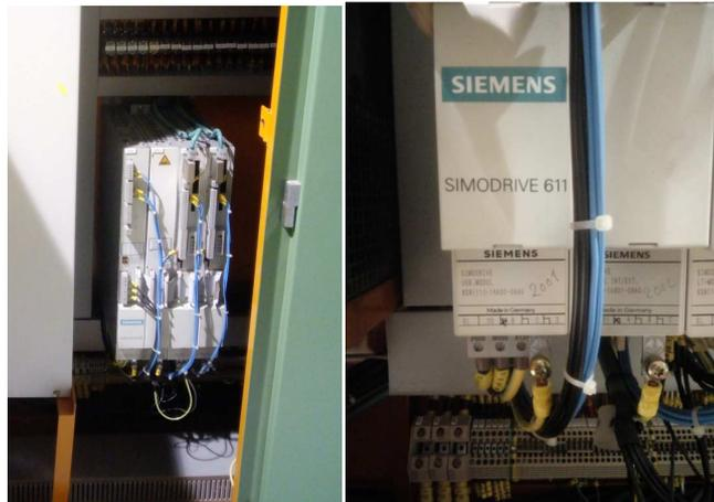
Figura 3-12: Simodrive 611. Conexión 600V CC en módulos de vigilancia y resistencias
