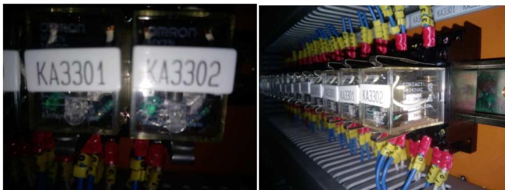
Figura 3-30: Contactores auxiliares de instrumentación y accionamientos Omron
