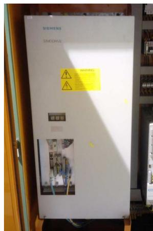
Figura 3-7: SIMODRIVE 660 Instalado
