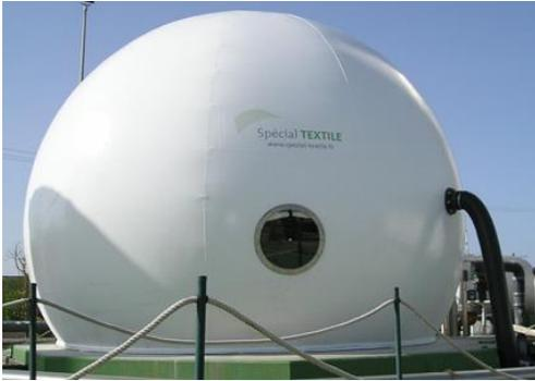
El gas que se produce de las reacciones del biodigestor se puede almacenar en un gasómetro que puede estar situado en la parte superior del reactor, o bien, puede estar separado del biodigestor (Figura 24).
