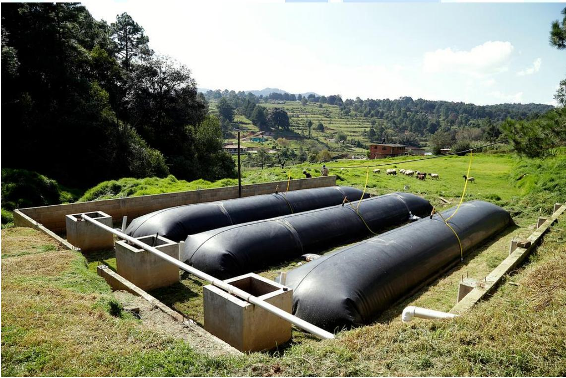
*Figura 11. Sistema de biodigestores en México*
