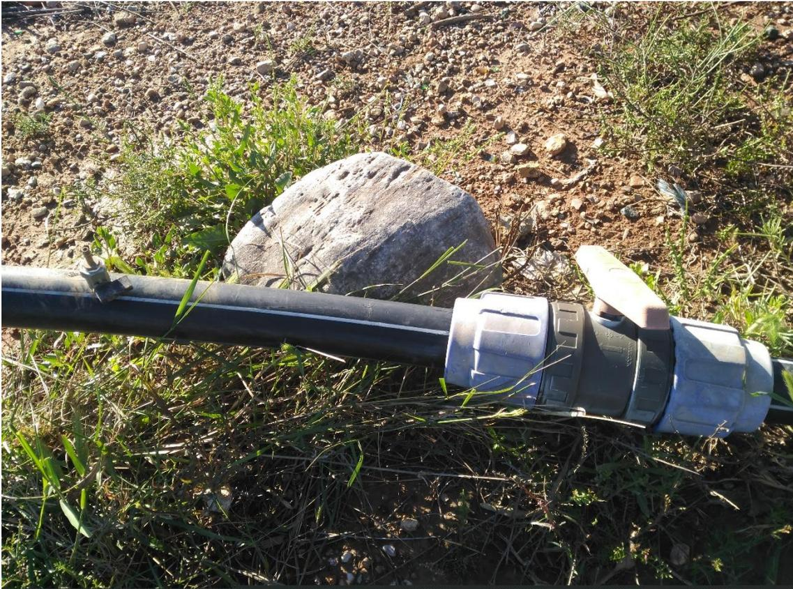
*Figura 40. Válvula de retención y válvula de medición, El Gorguel (Cartagena, Murcia)*
