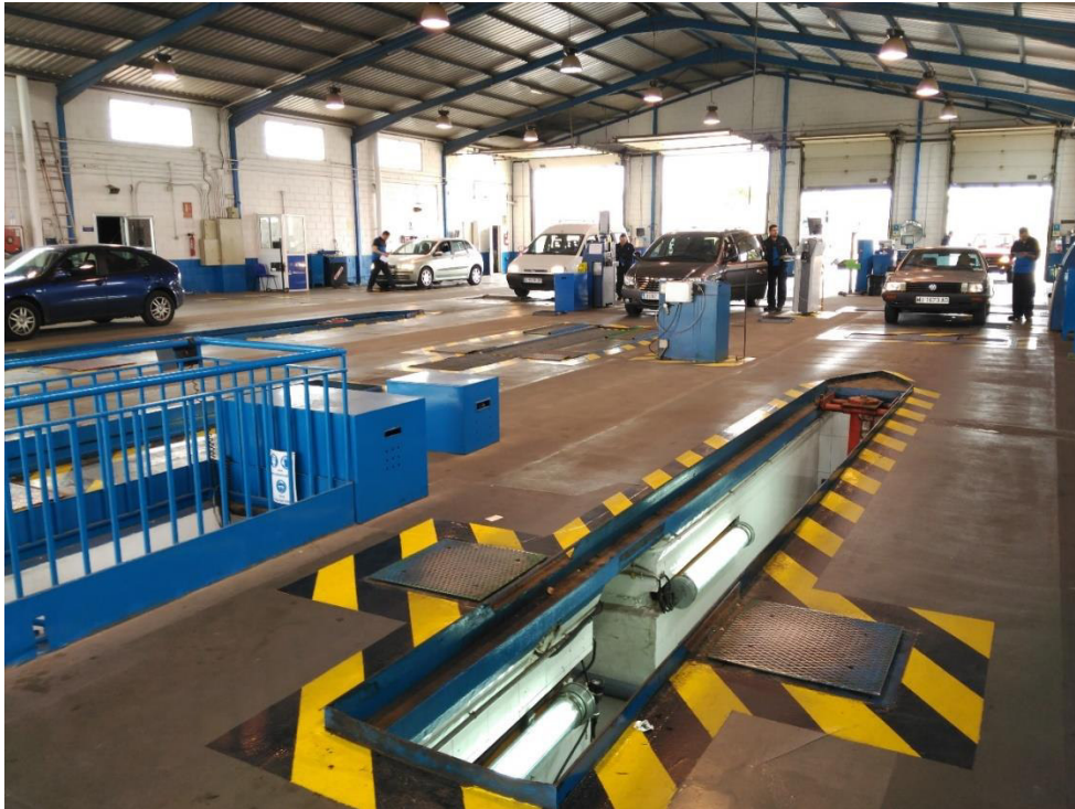
Figura 1.5. Foso desde donde se realiza la inspección de la parte inferior del vehículo.
