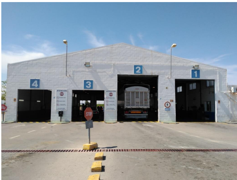
Figura 1.3. Entrada de vehículos (zona 1) donde se llevan a cabo operaciones de medida de gases.
