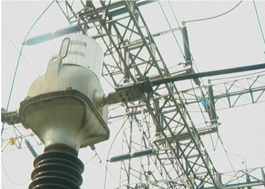
Figura 35. Imagen real de una conexión a temperatura excesiva.
