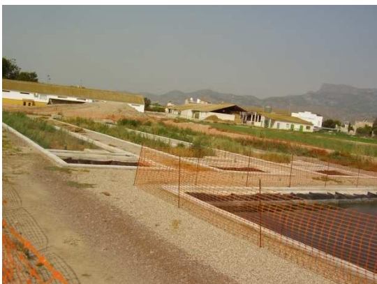
Foto IV.1.- Instalaciones del CIFEA.
