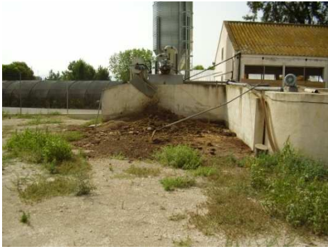
Foto IV.3.- Separación de sólidos.
