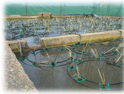
Foto II.4.- Depuradora Barbadillo (Ávila).
