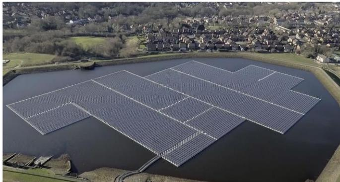
Figura 12. Planta fotovoltaica flotante Godley Reservoir Floating Solar PV.
