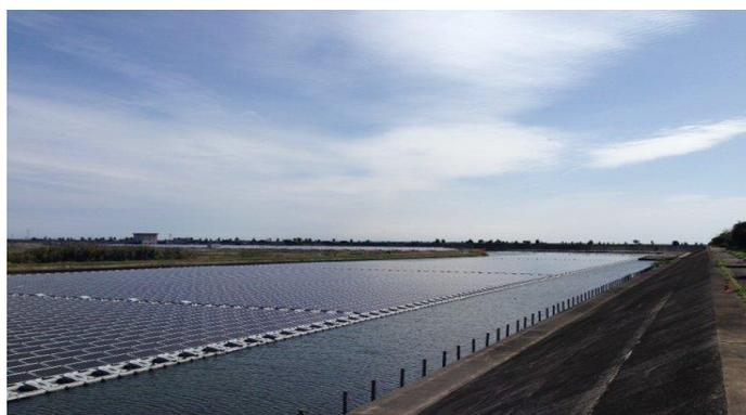
Figura 15. Planta fotovoltaica flotante en Sohara Ike.
