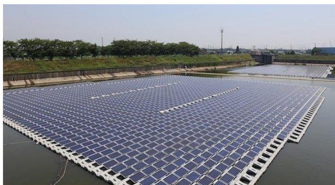
Figura 19. Instalación fotovoltaica con el sistema de flotación Hydrelío.
