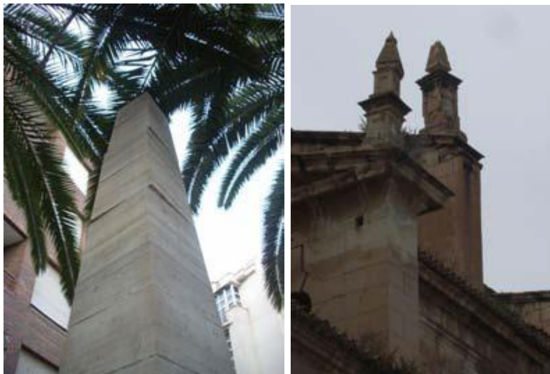
Rotación y giro del obelisco de la Carrera y giro de pináculos de la colegiata de San Patricio.
