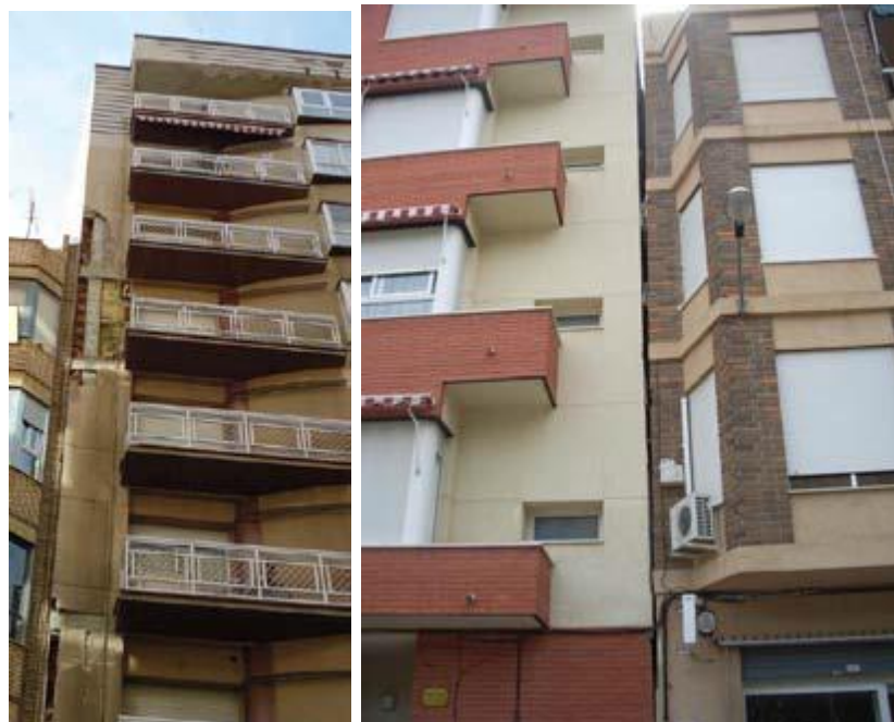
Daños por el choque de dos edificios de altura en Lorca.
