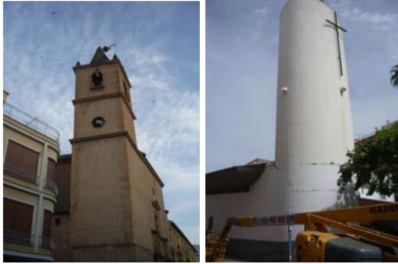
Torres de iglesia nuevas y viejas dañadas por el terremoto
