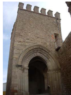
Deriva de muro de carga en torre medieval de la muralla
