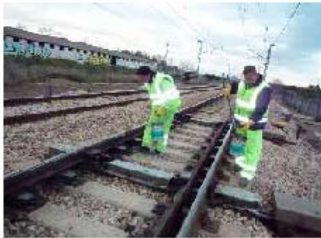
Figura 2. Actividad de engrasado de aparatos de vía
