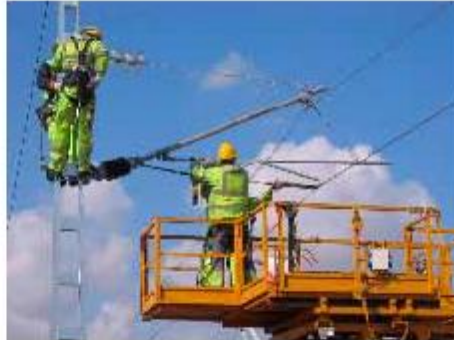
Figura 3. Actividad de ajuste de elementos de compensación mecánica
