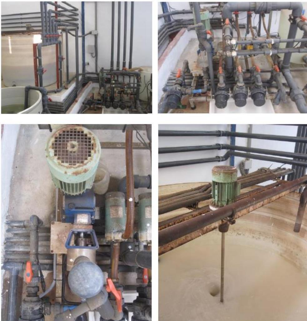
Fotografías 9, 10, 11 y 12: Sistema de fertirrigación en la explotación agrícola El Aguilucho de FRUGARVA S.L.
