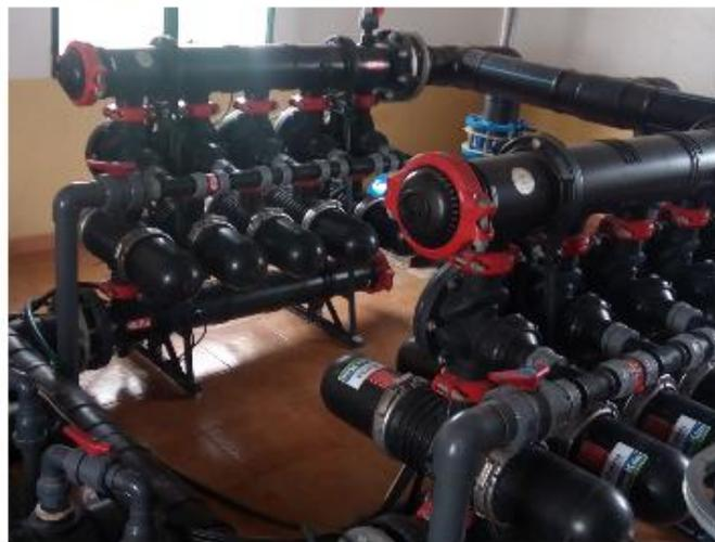
Fotografías 6, 7 y 8: Sistema de fertirrigación en la explotación de Frutas Esther S.A.
