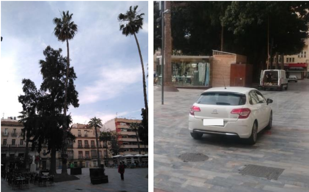
Figura 15. Punto 10 anillo interior: Plaza San Francisco - Esquina Correos
