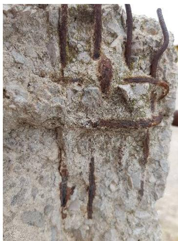
Figura 12 Degradación del hormigón
