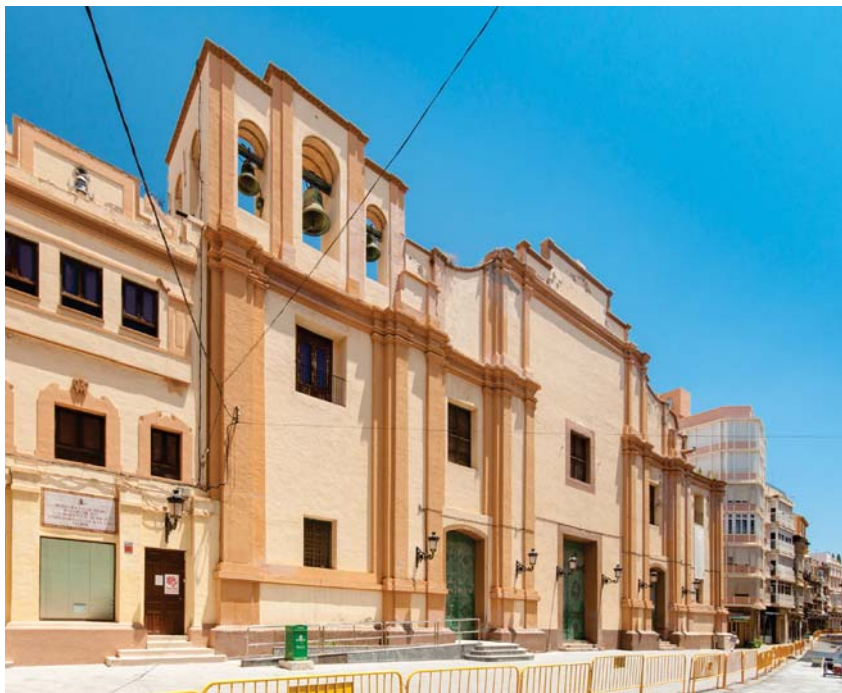
[03] Fachada inconclusa de la iglesia.
