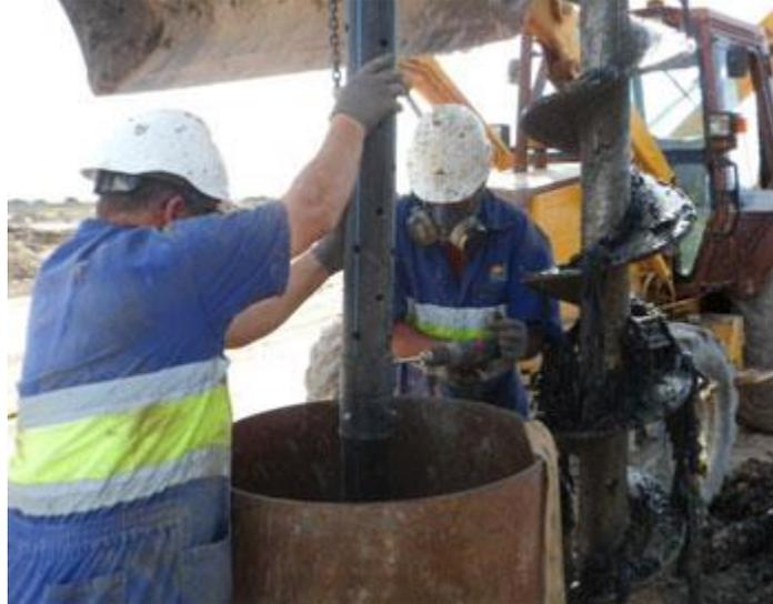
**Imagen 3.3.1 a** Tubería interior perforada, **Fuente:** Sondeos puebla, perforación e investigación
