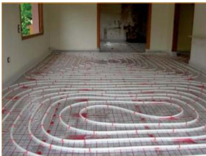
*Ilustración 26: Instalación geotérmica y aplicación en suelo radiante (network, 2015)*
